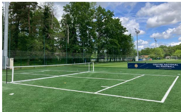
POSE PAR INCRUSTATION SUR UN TERRAIN EN GAZON SYNTHÉTIQUE EXISTANT Clairefontaine (Yvelines)
